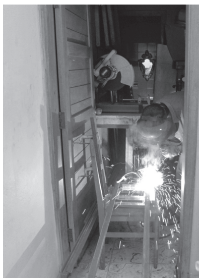
Figura 6. Construcción de elevadores y silos de almacenamiento. Elaboración propia.
